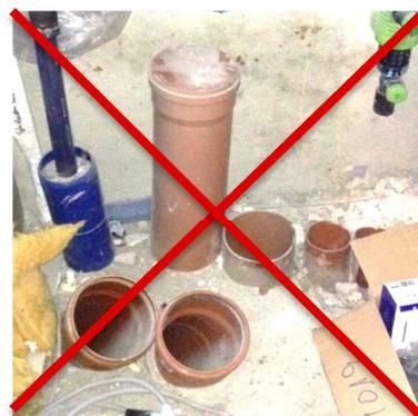
Die Gebäudeeinführung durch das Mauerwerk in den Keller bzw. durch Fundament und Bodenplatte muss entsprechend dem technischen Regelwerk mindestens gas- und wasserdicht, für Gashausanschlüsse zusätzlich verdreh- und auszugssicher, erfolgen. Ein entsprechend zugelassenes Hauseinführungs- bzw. Leerrohrsystem muss für Gebäude ohne Keller in der Bauphase durch den Anschlussnehmer eingebracht werden. Bei Gebäuden mit Keller kann dies nachträglich mittels Kernbohrung erfolgen.
