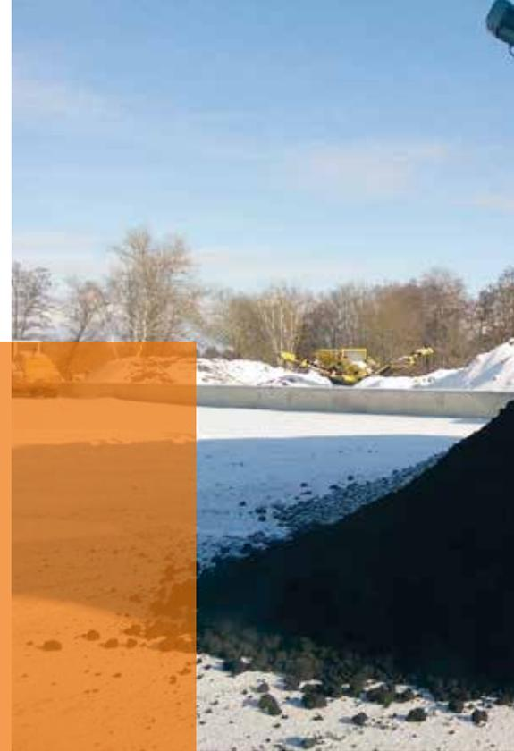
**Jährlich fallen auf der Kläranlage Briest viele Tonnen Klärschlamm an. Dieser entsteht als Abfallprodukt der biologischen Abwasserreinigung und ist eine Mischung aus Wasser und Feststoffen. Bei letzteren handelt es sich zum einen um im Abwasser vorhandene Schwebstoffe, die sich in der Vorklärung absetzen, zum anderen um Biomasse, die anfällt, da sich die Mikroorganismen beim Abbau der im Abwasser enthaltenen Nährstoffe vermehren.**
